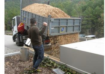
Foto 3: Carga de astilla por gravedad. CTFC
